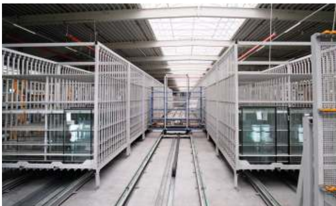
Die vollautomatischen Glaspuffer führen die Isolierglaseinheiten über ein Shuttle synchron zu den Elementen der Verglasung zu
